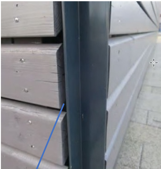
Fugenbreite mind. 8 mm waagrecht
