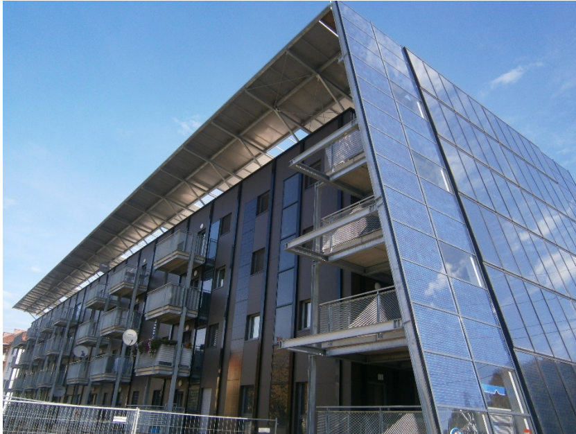
Plusenergiesanierung Wohnbau, Kapfenberg, A, 2014 Arch Nussmüller & AEE INTEC, 2014 © AEE INTEC
