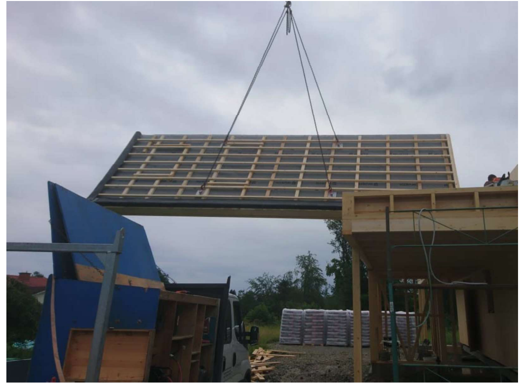
Montage Dachelemente
