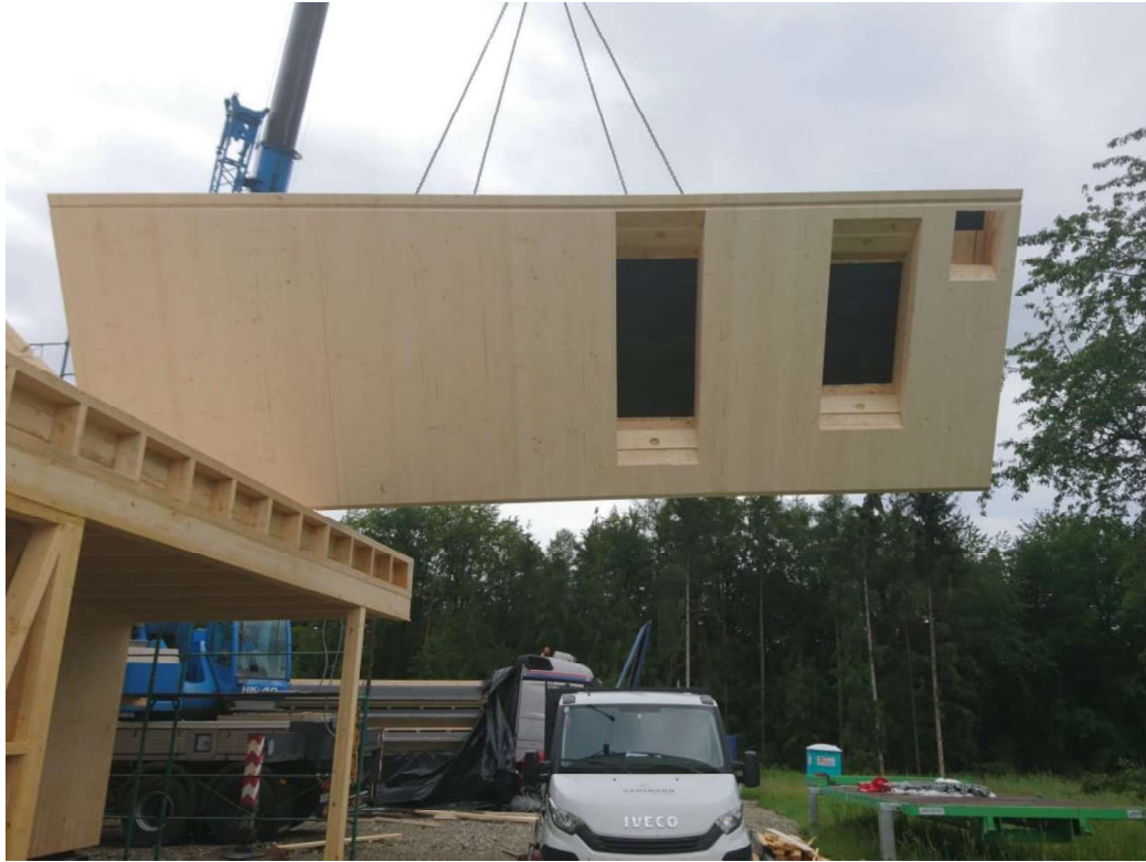
Montage Dachelemente
