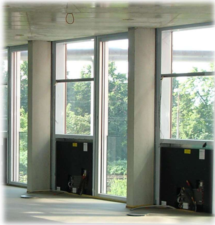
Capricorn Düsseldorf / Deutschland (Komponenten der dezentralen Gebäudetechnik in der Fassade)
