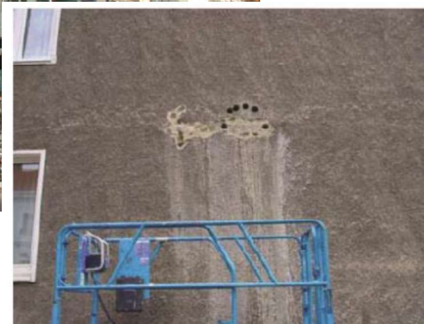
Kernbohrung in der Außenwand
