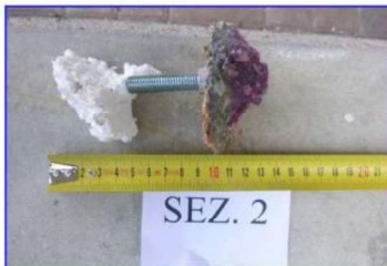
Misura della carbonatazione
