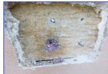
Misura della carbonatazione
