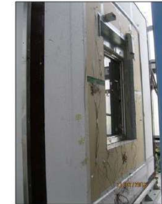
Figure 5: Montaggio sensori lato freddo.
