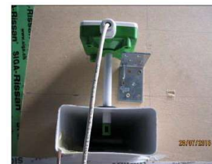
Figure 4: Montaggio anemometro sistema di ventilazione.
