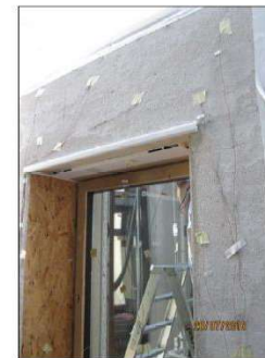
Figure 3: Montaggio sensori lato caldo.
