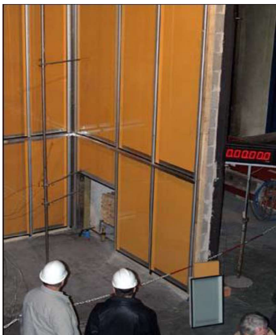
Prüfaufbau vor Beginn
