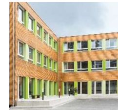
© ERNE AG Holzbau Foto: tm studios
