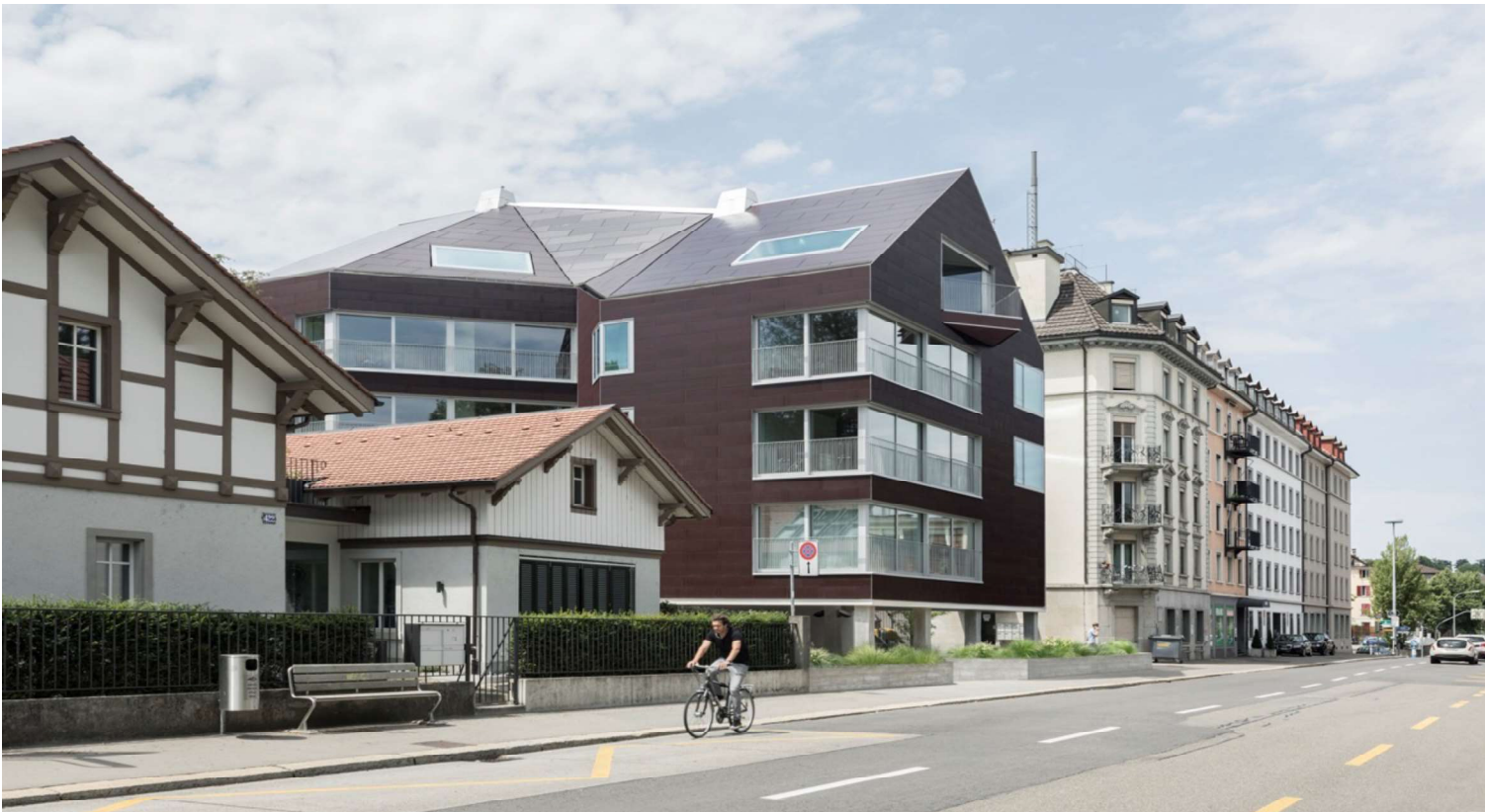
BIPV-Fassade mit roten Solarmodulen von Ertex Solar
