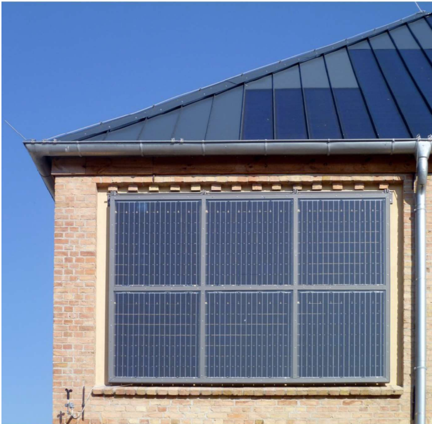
Der Kornspeicher in Nechlin: Ausführung Solarfassade und Dach
