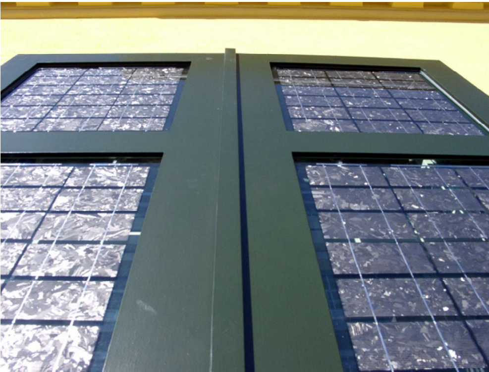
Solare Fensterläden mit grauen, monokristallinen Solarzellen und Holzrahmen
