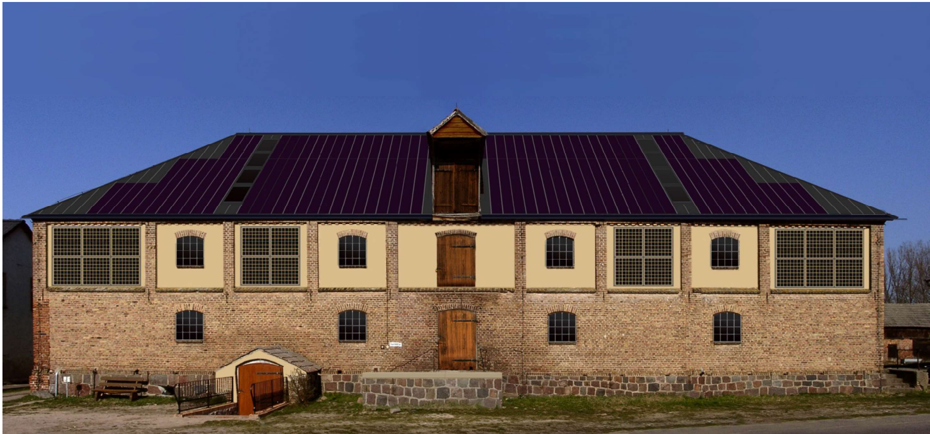
Der Kornspeicher in Nechlin: Animation Planung
