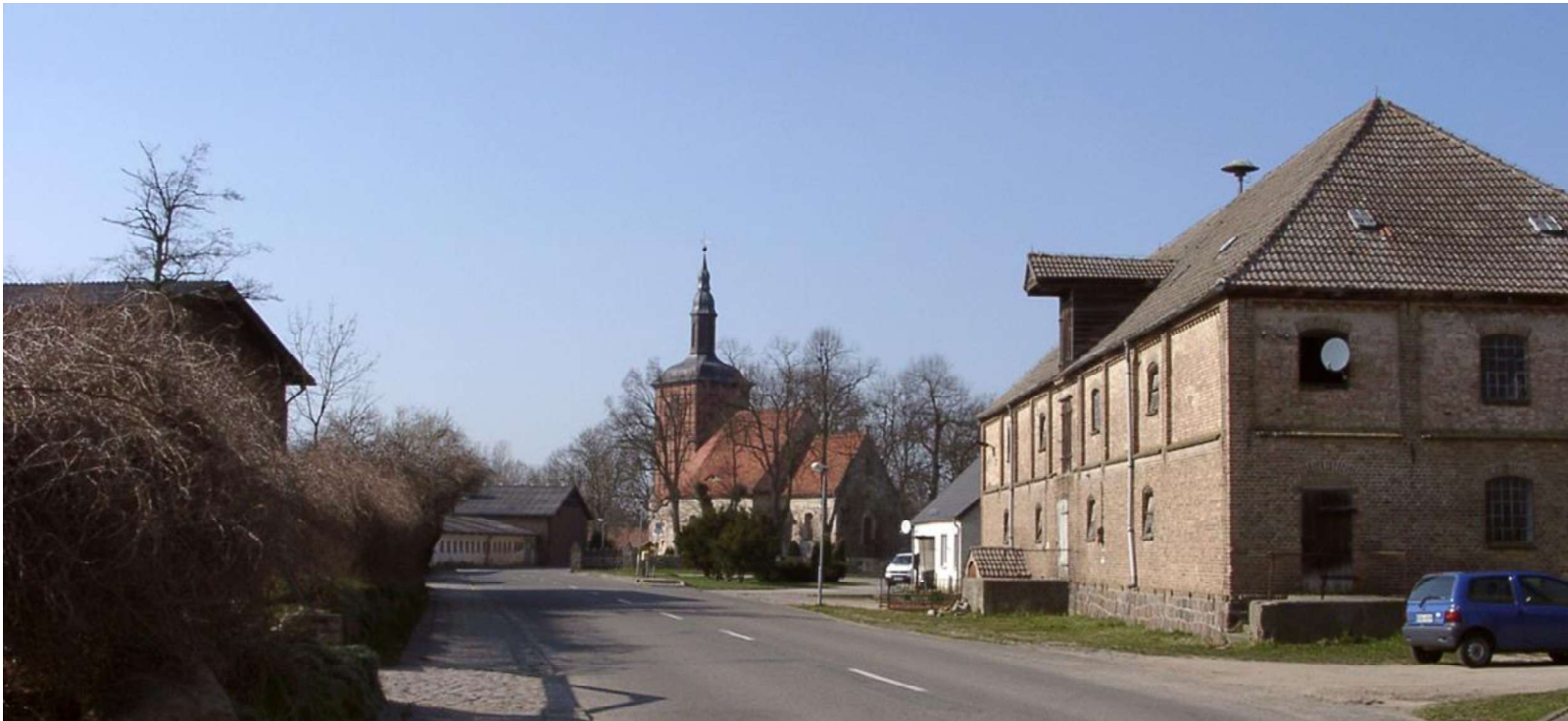
Das Energiedorf Nechlin vor der Sanierung
