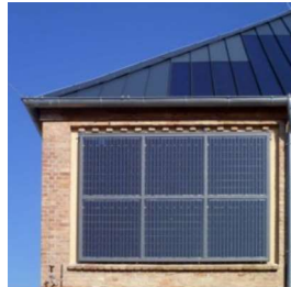
Solarspeicher, Nechlin vor Sanierung
