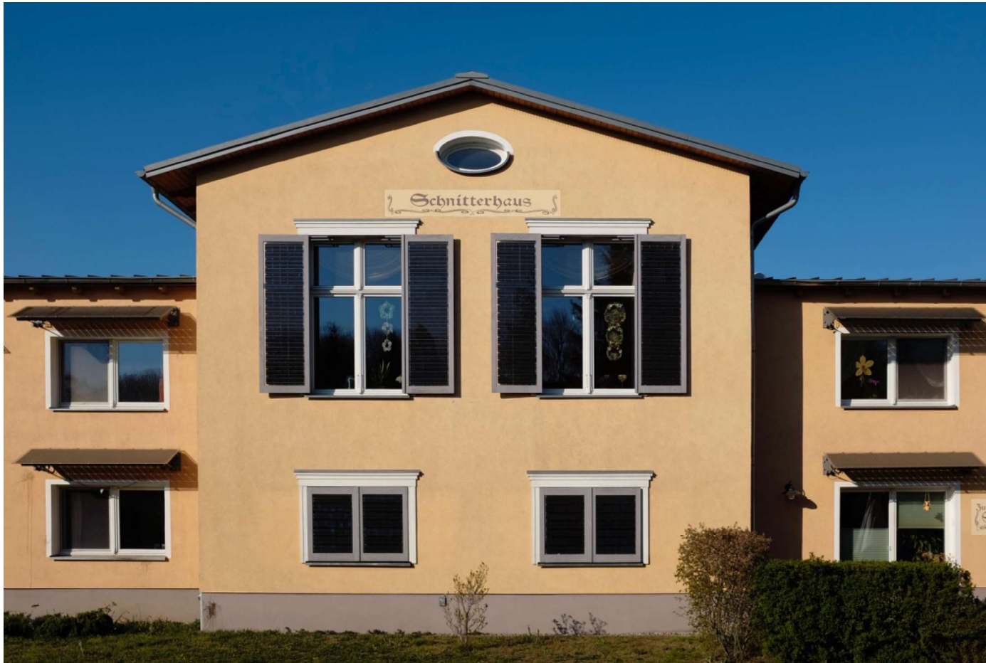
Das Energiedorf Nechlin – Schnitterhaus mit Solaren Fensterläden
