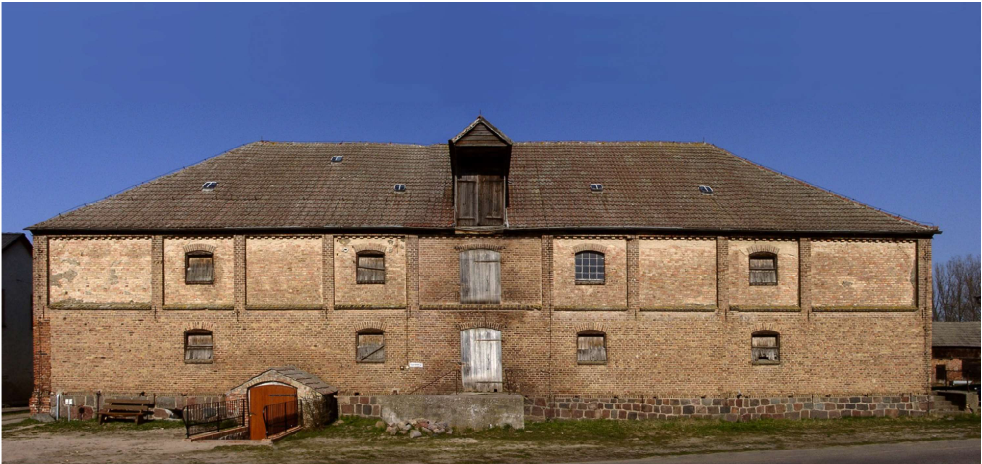
Der Kornspeicher in Nechlin vor der Sanierung
