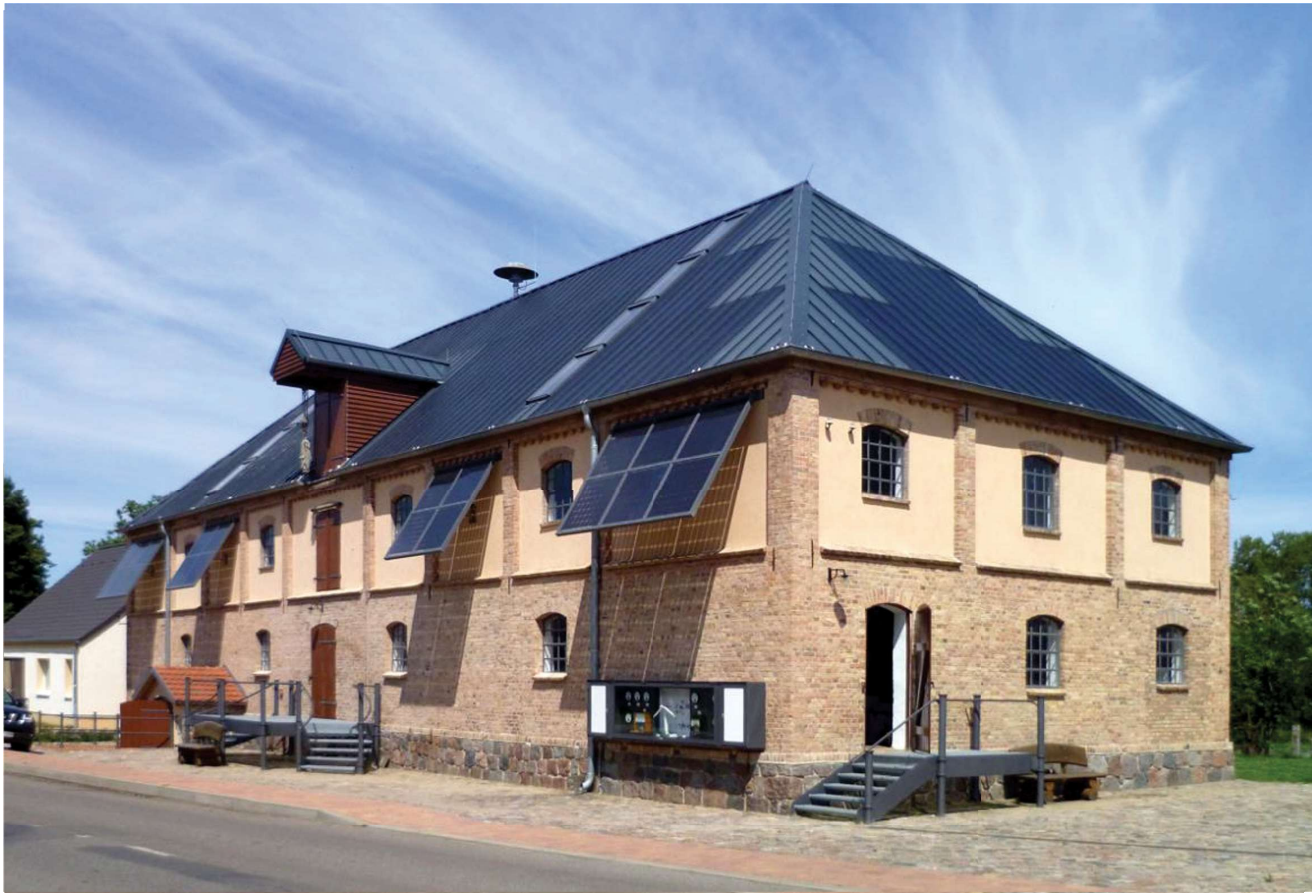
Der Kornspeicher in Nechlin: Ausführung Solarfassade und Dach
