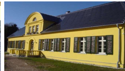
Solare Fensterläden am Solarzentrum MV
