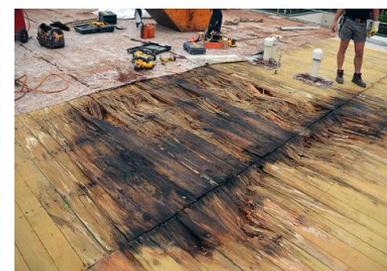
Abb. 1: Schadensbeispiel 1 – Unbelüftetes Holzflachdach nach vier Jahren
