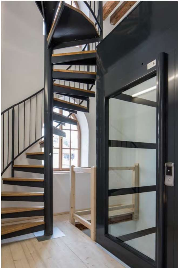
Schlauchturm Wendeltreppe - Spitze
