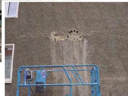
Kernbohrung in der Außenwand
