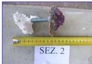
Misura della carbonatazione
