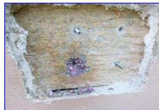
Misura della carbonatazione
