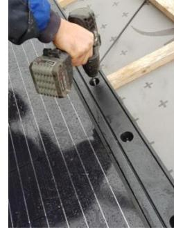
5. Module von unten nach oben, von rechts nach links eindecken. Punktbelastungen vermeiden, zur Begehung Leiter/Bohle zur Lastverteilung auflegen
